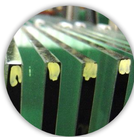
Markierung nach Heat-Soak-Test
